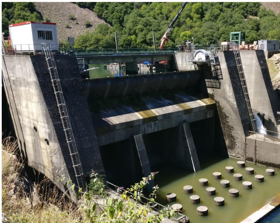
Les travaux de fiabilisation et de modernisation des évacuateurs de crue du barrage de Plan d'Arem sont arrivés à leur terme. Ces travaux consistaient à mettre en place des vannes neuves et un système de motorisation pour améliorer leur fonctionnement.
