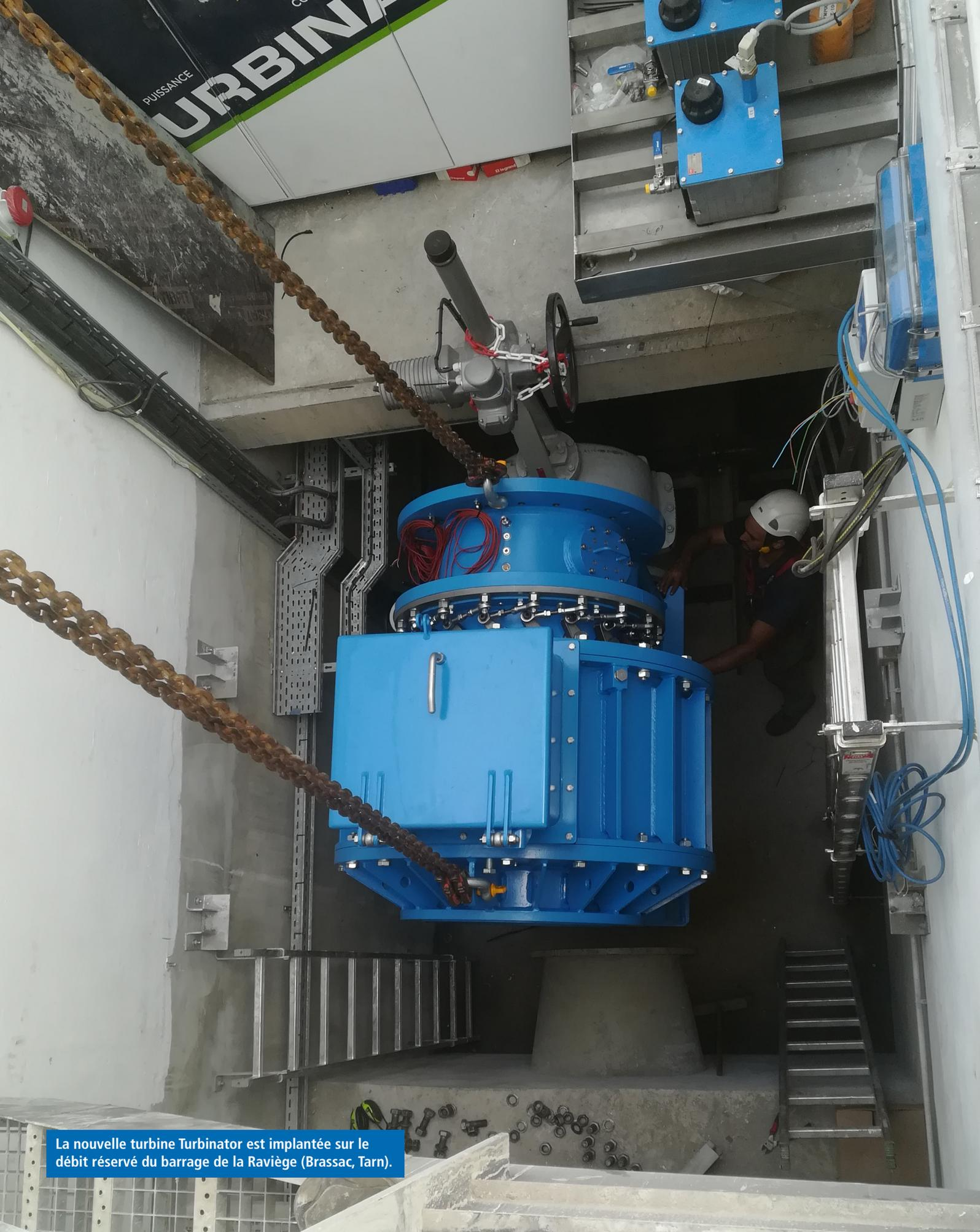
La nouvelle turbine Turbinator est implantée sur le débit réservé du barrage de la Raviège (Brassac, Tarn).
