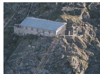
STEP, c'est le diminutif des Stations de Transfert d'Énergie par Pompes. Le principe est de pomper l'eau et de la stocker dans des bassins d'accumulation lorsque la demande d'énergie est faible (la nuit), pour la turbiner quand la demande est forte (le jour).
